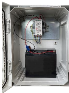
Coffret Éclairage Public
